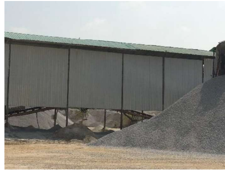
รูปที่ 2-17: อาคารปิดคลุมชุดตะแกรงร่อน
