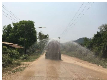
รูปที่ 2-23: การฉีดพรมน้ำบริเวณเส้นทางลำเลียงแร่
